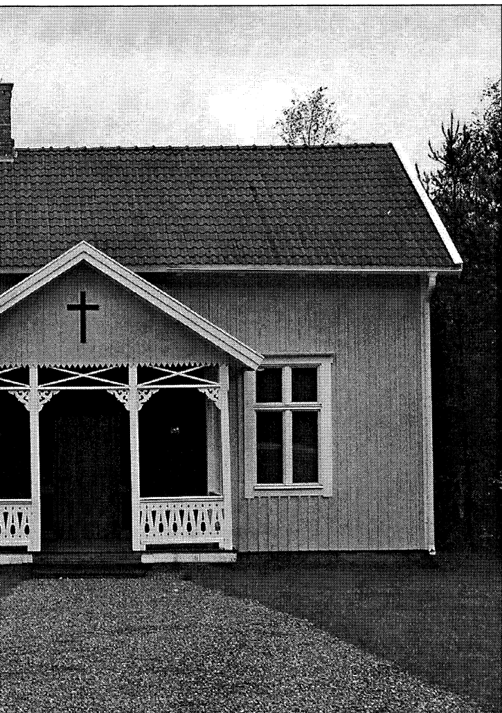
1913. Här undervisades barnen i 24 år, innan man fick ta n som byggdes med stolpresning och sågspånsfyllning i
